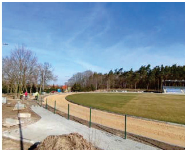
Stadion miejski przy ul. Sportowej w trakcie przebudowy
