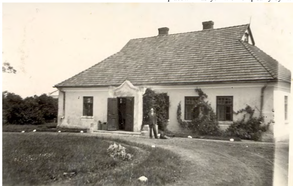
Dworek w Opatowicach, rok 1939.
