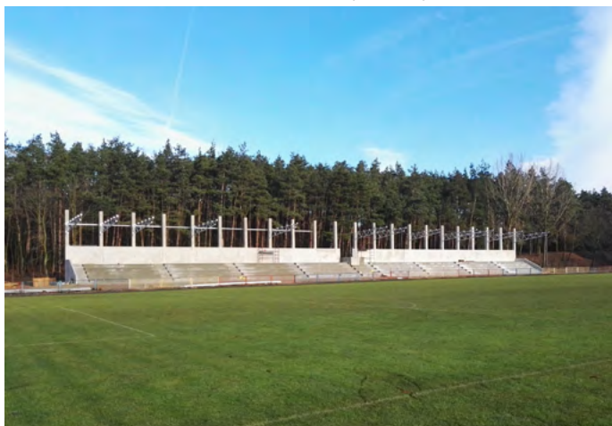
Budowa północnej trybuny
