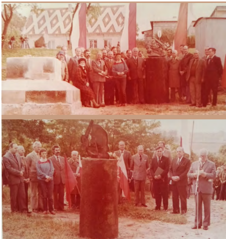
Fot. 4 - 27.IX. 1986r. - wmurowanie aktu erekcyjnego
