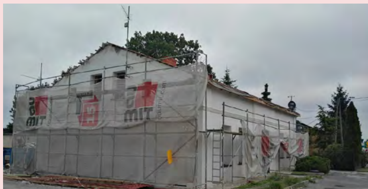
Mieszkanie na komunalnej w trakcie ocieplania
