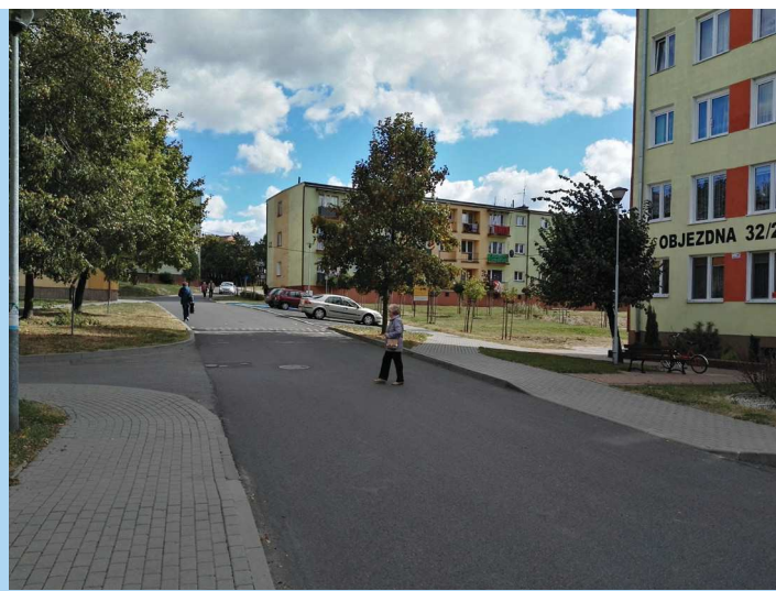
Inwestycja wokół bloku nr 28/6 przy ul. Objezdnej
