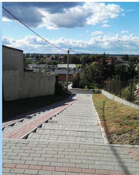
Schody przy ul. Stromej
