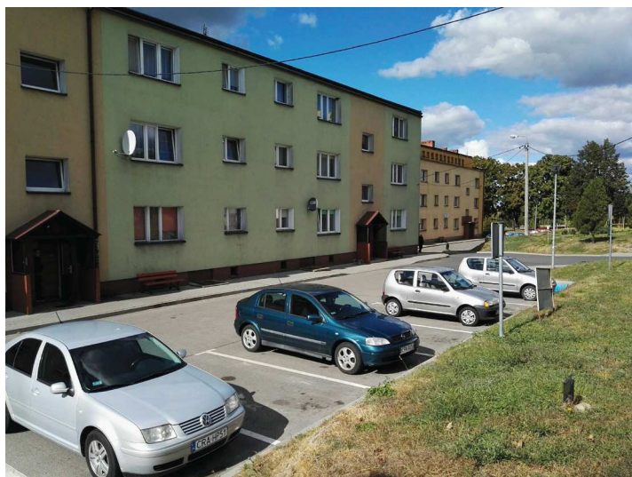
Inwestycja wokół bloku nr 32 przy ul. Objezdnej
