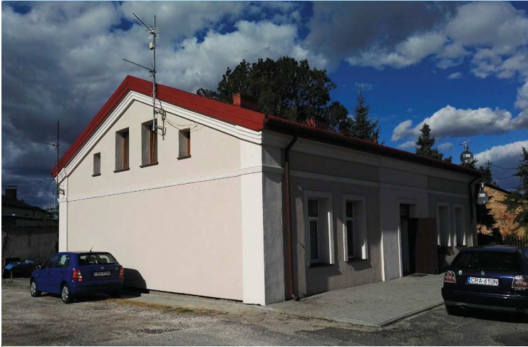
Zmodernizowany budynek przy ul. Brzeskiej 49
