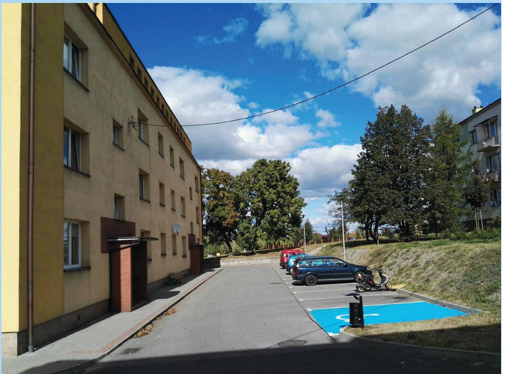
Inwestycja wokół bloku nr 25/15 przy ul. Objęzdej
