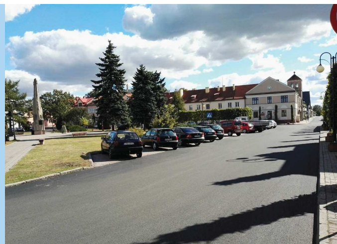
Przywrócona nawierzchnia asfaltowa na ul. Rynek
