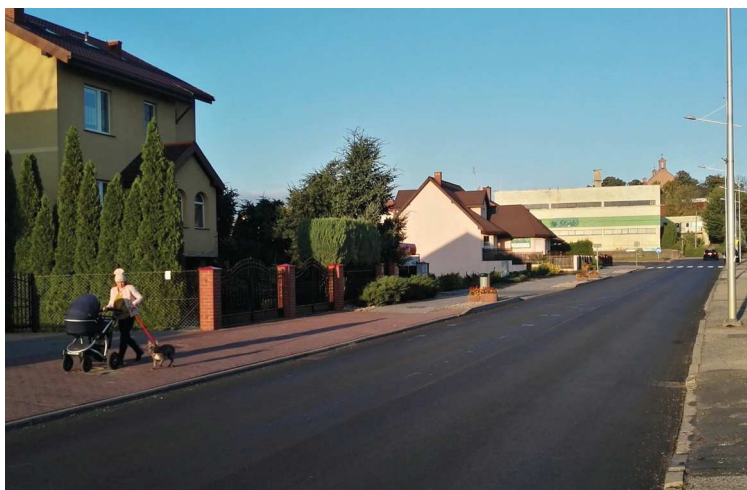
Przywrócona nawierzchnia asfaltowa na ul. Kruszwickiej
