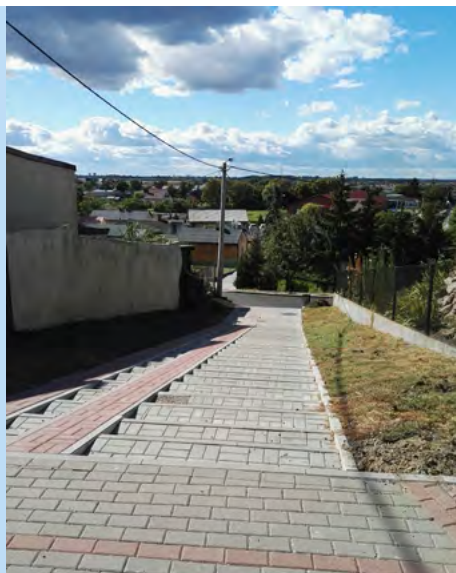
Schody przy ul. Stromej
