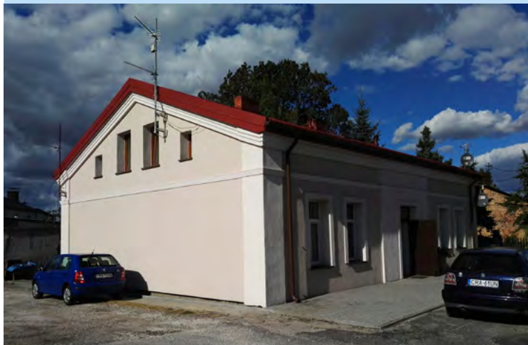
Zmodernizowany budynek przy ul. Brzeskiej 49
