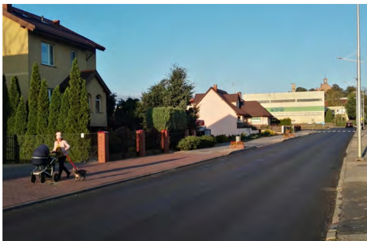
Przywrócona nawierzchnia asfaltowa na ul. Kruszwickiej
