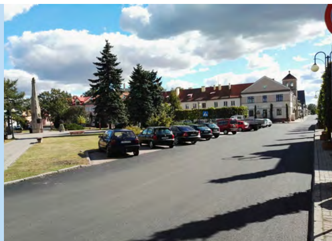
Przywrócona nawierzchnia asfaltowa na ul. Rynek
