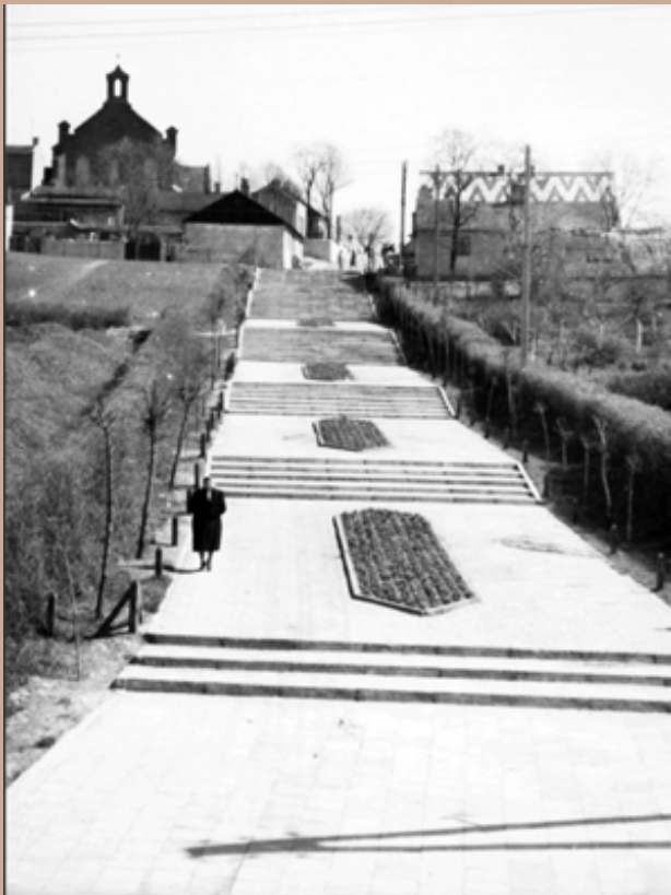
Schody przy ul. Kruszwickiej (obok dzisiejszej radziejowskiej biblioteki i pomnika T. Kościuszki) - koniec lat 60-tych
