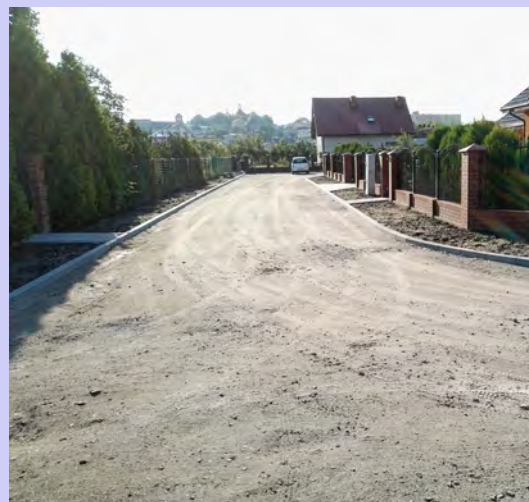
ul. Prusa - w trakcie budowy
